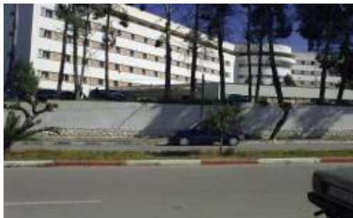
Hôpital Mohamed V à Meknès
