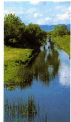
Le cours rectiligne du Drugeon après les travaux de redressement à la pelleuse.
