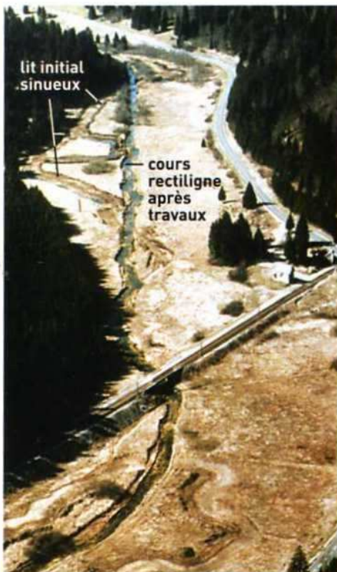
Vue aérienne des travaux de rectification du cours du Drugeon.
