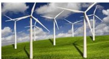
استغل الإنسان منذ القدم قوة الرياح للحصول على الطاقة الميكانيكية، أما حاليا فيعتمد على مراوح كبرى تركيب في الأماكن التي توجد فيها الرياح قوية باستمرار و ذلك لتحريك منوبات تنتج الطاقة الكهربائية.
